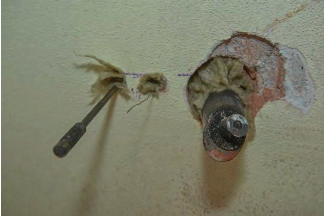
Afbeelding 14: Sensoren gasanalyseapparaat en stralingsmeter door muur van de burens
