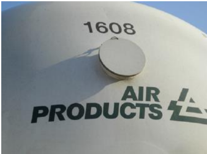
Afbeelding 8.2 Blow-off disc
