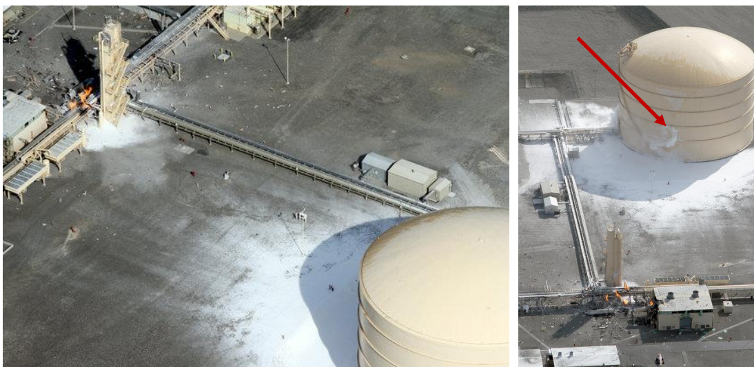
Afbeelding 9.3 en 9.4 Uitstroom LNG en gasbrand
