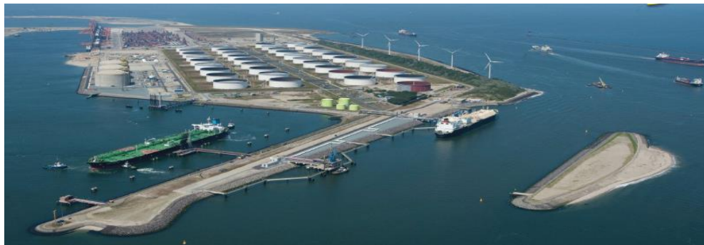
Afbeelding 3.7 The Gate terminal, Rotterdamse haven
