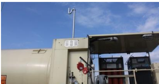
Afbeelding 4.10 Afblaaspijp afleverinstallatie
