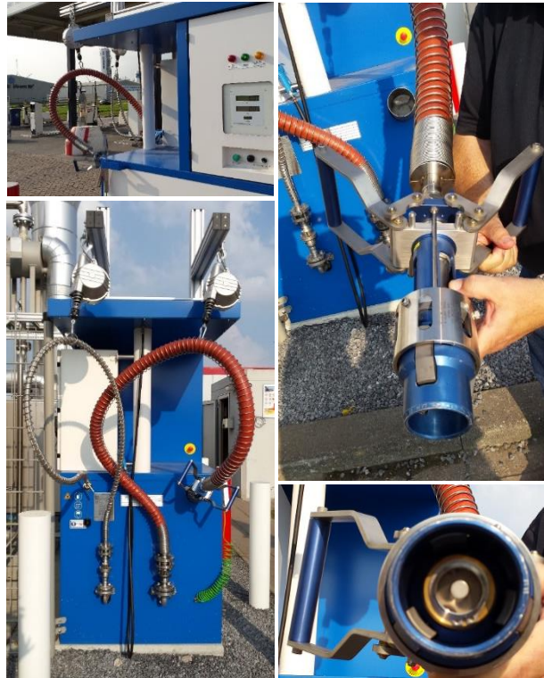
Afbeelding 7.5 LNG-afleverzuil met afleverslang en koppeling
