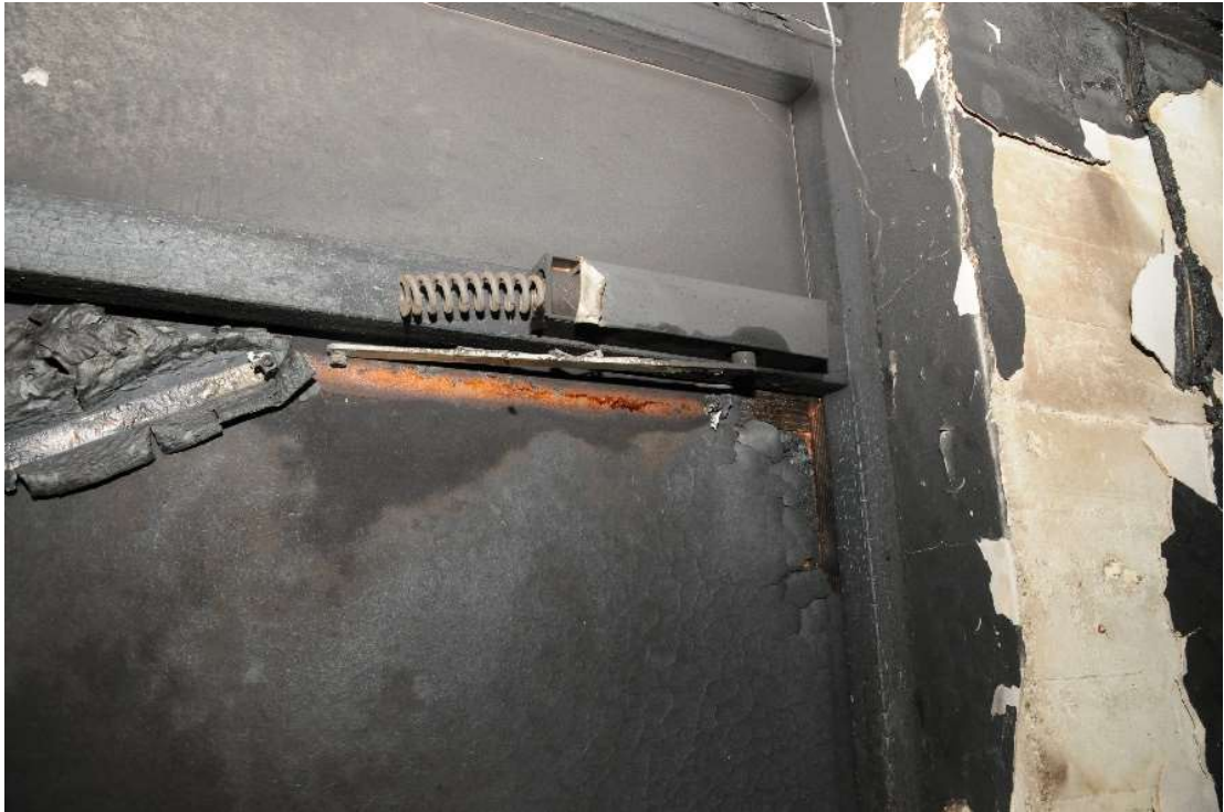
Figuur 3.4 Sluitmechanisme deur naar het centrale trappenhuis
