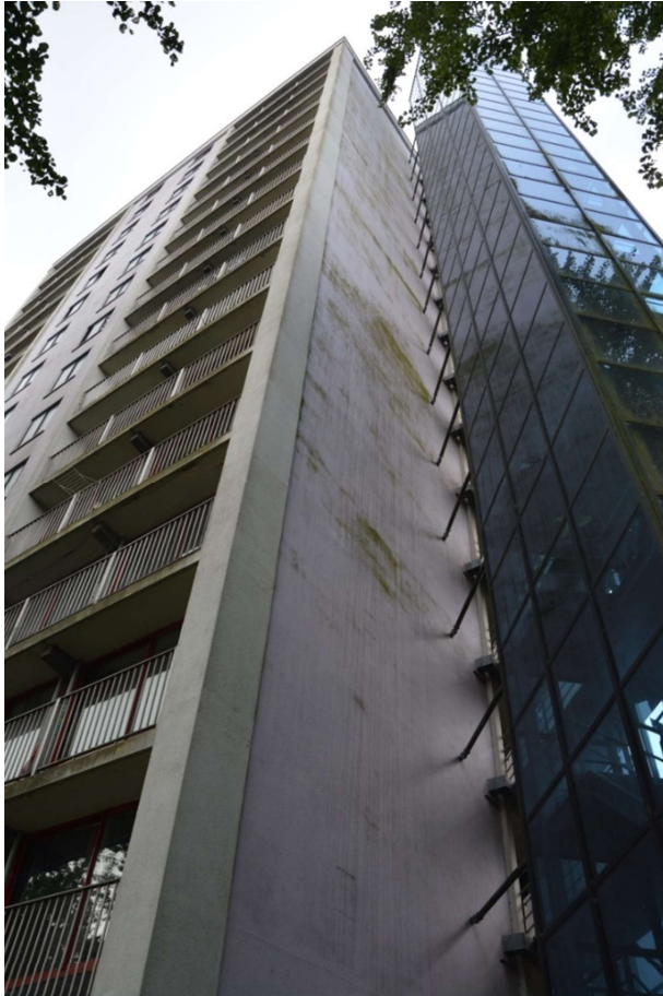
Figuur 2.3 Zijaanzicht van gebouw met vluchttrappenhuis
