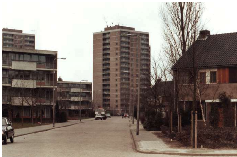
Figuur 2.2 De studentenflat voor de bouw van het vluchttrappenhuis 6
