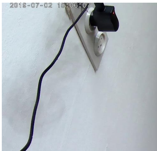
Figuur 3.32 Rookverspreiding via een wandcontactdoos met CAI-aansluiting in woning 2.19 tijdens test 13 van variant 5
