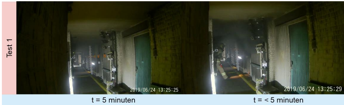
Figuur 3.6 Rookverspreiding naar gang 1.2 vlak voor en na het openen van de deur van de brandruimte tijdens test 1 van variant 0
