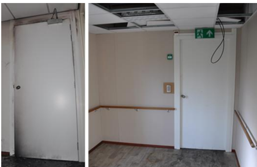
Figuur 5.10 Foto links: deur aan de binnenzijde van het trappenhuis op de eerste verdieping, foto rechts: deur trappenhuis op de begane grond vanuit de gang gezien
