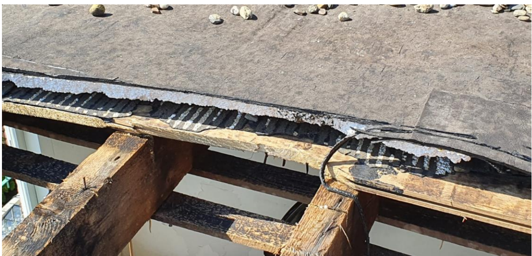
Figuur 7: Foto opbouw dakconstructie
