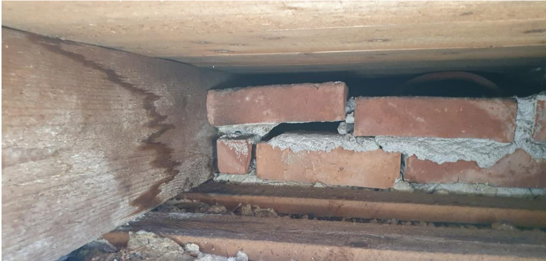
Figuur 8: Foto ruimte tussen onderzijde dakbeschot en bovenzijde verlaagd plafond
