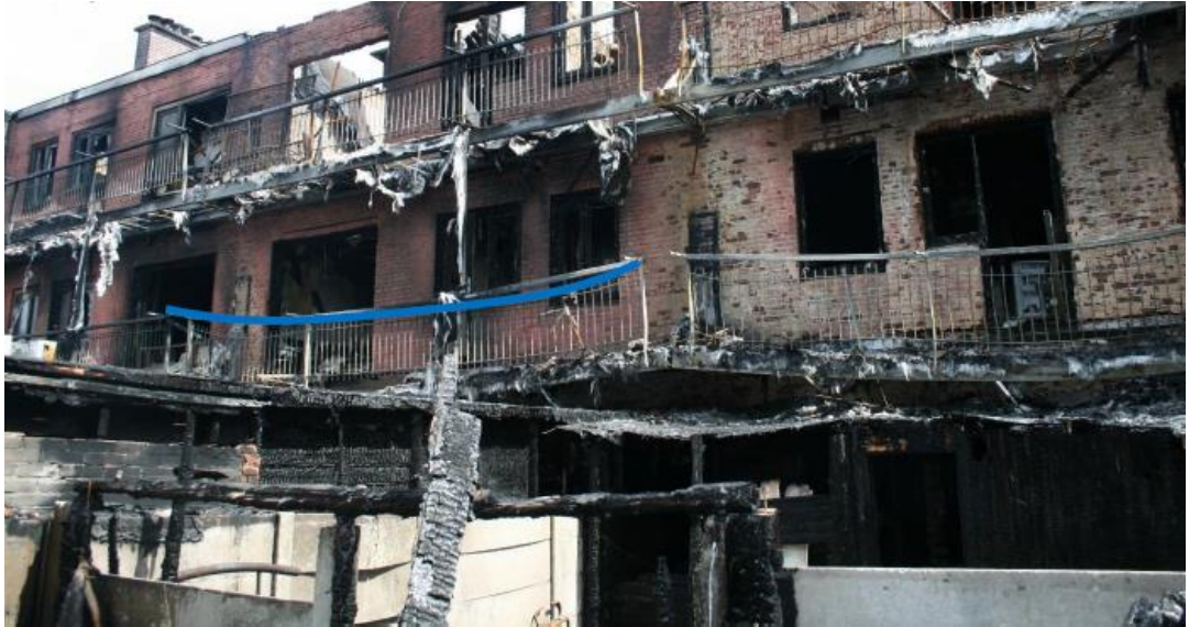
Figuur 6: Foto van de balkons en privacyschermen na de brand (bron: rapportage Team Brandonderzoek)
