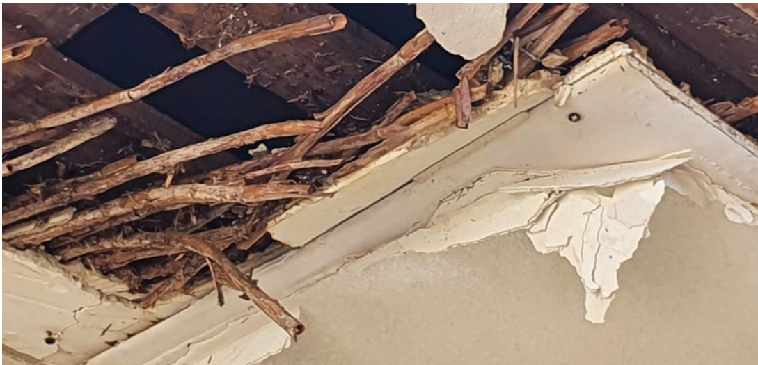
Figuur 9: Foto verlaagd plafond in woning
