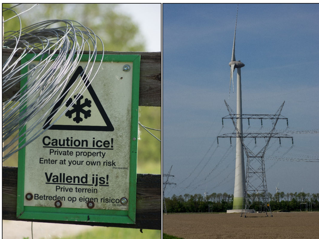
Figuur 5.2 Links: waarschuwing voor ijsval bij windturbine. Rechts: windturbine in de buurt van hoogspanningsmasten (Foto: Jeroen Eskens – Antea Group)
