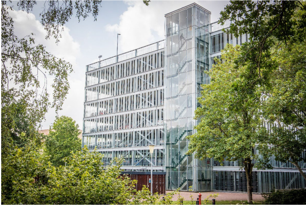
Afbeelding 5.1 Open parkeergarage (bron: Tom Hessels, IFV)
