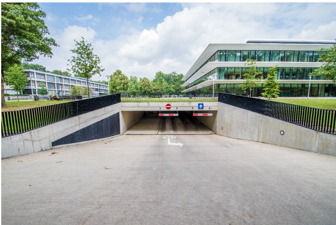
Afbeelding 5.4 Ondergrondse parkeergarage (bron: Tom Hessels, IFV)
