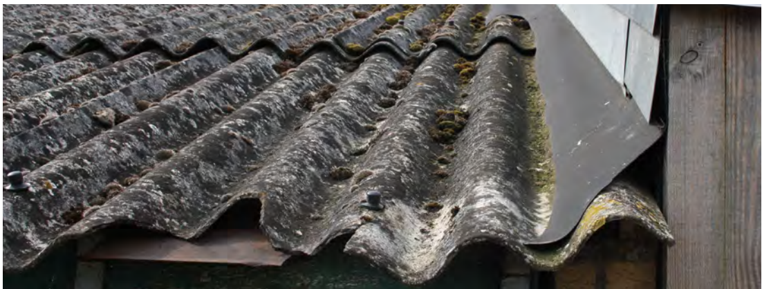
Afbeelding 2.1 Asbestcementgolfplaten
