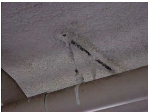
Afbeelding 2.2 Toepassing spuitasbest
