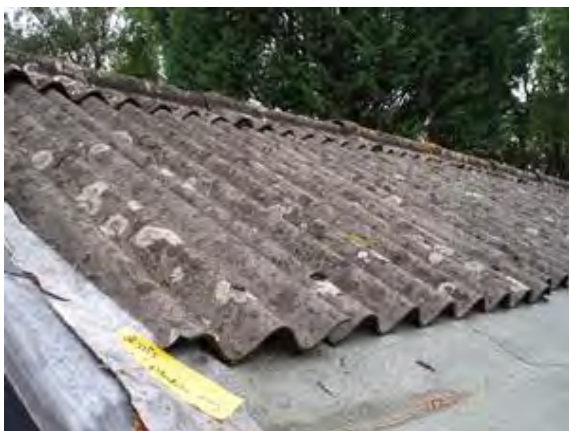
Afbeelding 2.4 Dak asbestcementplaten
