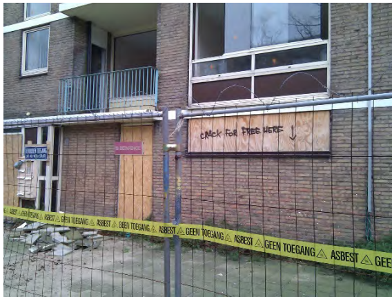
Afbeelding 3.4 Foto saneringslocatie met waarschuwingslinten
