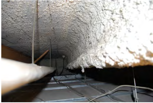
Afbeelding 1.4 Niet-hechtgebonden asbest
