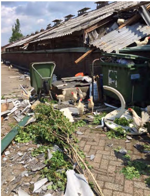
Figuur 1 Heusden, 19 mei 2015: kippenschuur met asbesthoudende golfplaten zwaar beschadigd door een windhoos. Fotograaf: Red een legkip.
