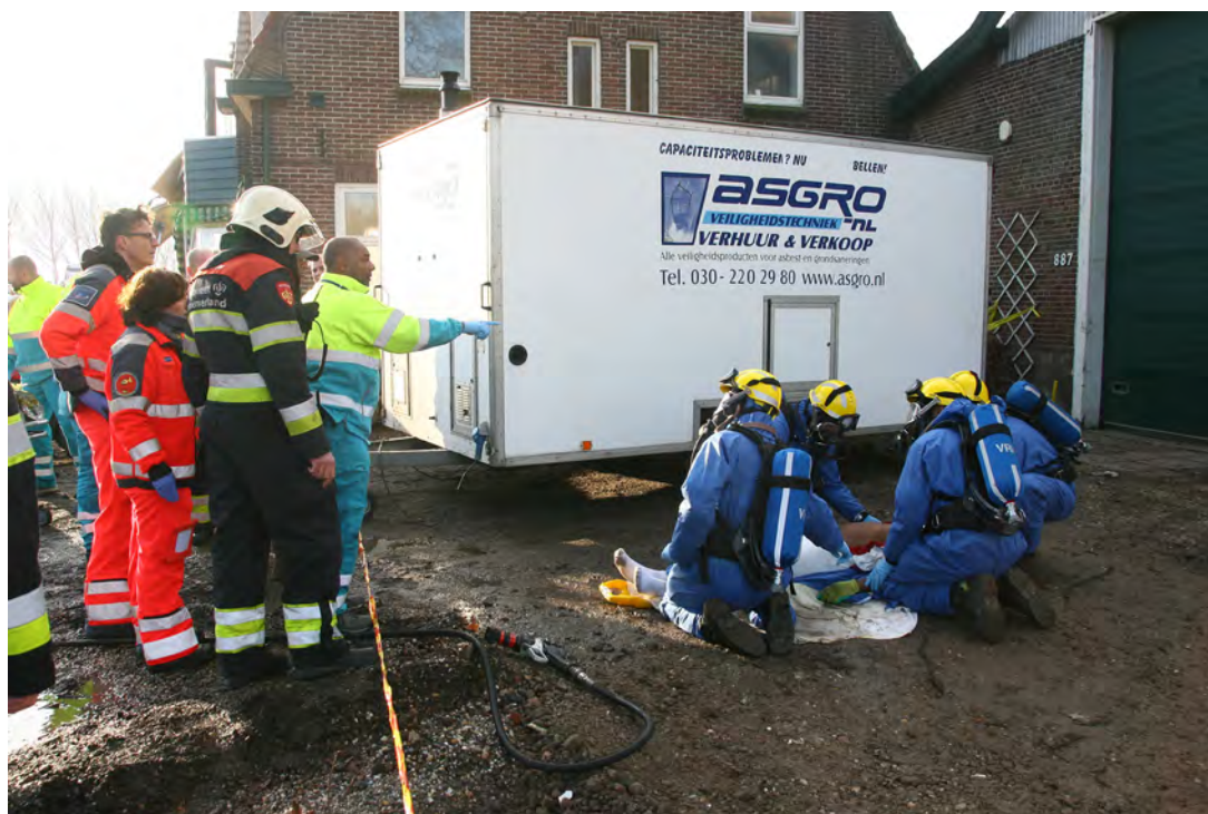
Afbeelding 8.4 Rijsenhout, 12 december 2013. Brandweerploeg ontsmet zwaar gewonde asbestsaneerder en verleent eerste hulp op advies van de ambulance
