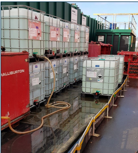
Figuur 1.1 Boven: boorinstallatie in Monster. Midden: boorinstallatie in nachtelijke uren. Onder: opslag van chemicaliën die nodig zijn in de boorfase.
