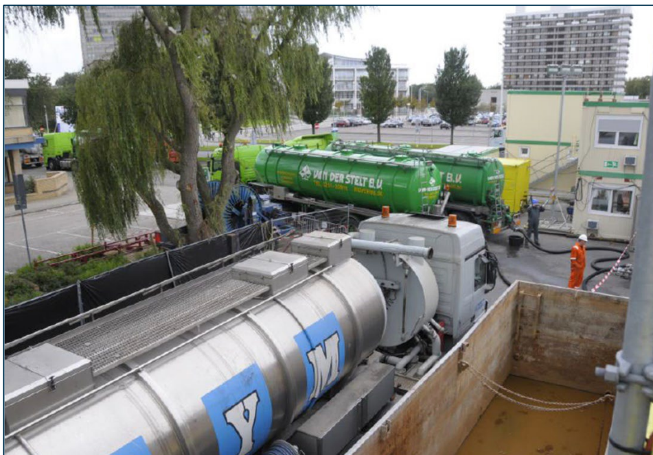
Figuur 4.1 Afvoer van formatiewater (bron: Handboek geothermie )
