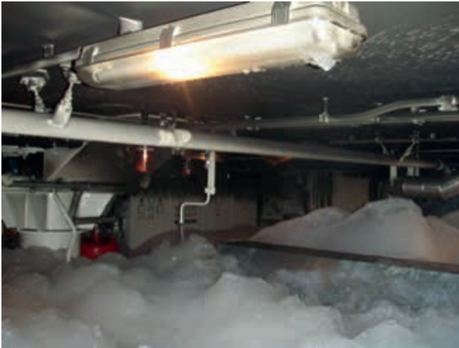
Figuur 6 Resultaat van de schuiminzet in de machinekamer
