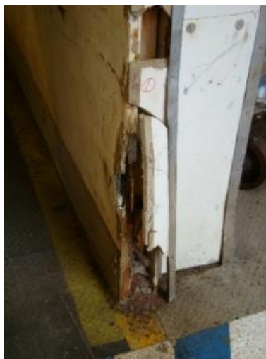
Figuur 29 – Scade aan een compositete barrière
