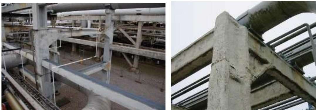
Figuur 43 – Voorbeelden van onbeschermdede bovenflenzen op balken
