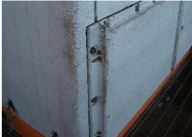
Figuur 23 - Epoxy –opschuimende dry-fit constructie met afgedichte scharnieren
