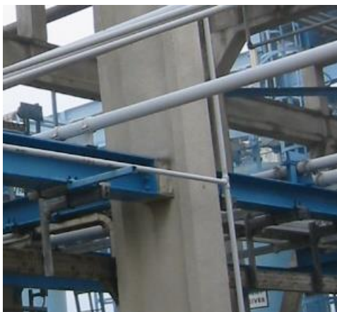
Figure 46 - Structureel staalwerk zonder coatback
