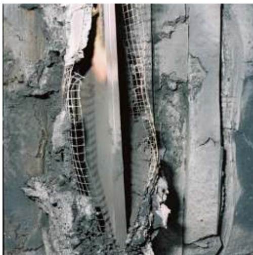
Figuur 39 – Termination falen van versterkte wapening
