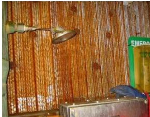
Figuur 20 – Corrosie van het retentiesysteem voor Man-Made Mineral Fibre (MMMMF)
