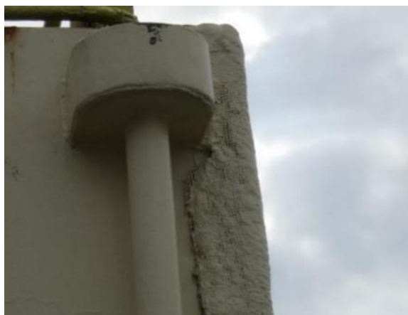
Figuur 14 – Slecht randafwerking met PBB
