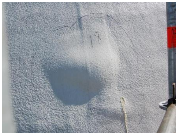
Figuur 15 – Blaren op epoxy PBB-materiaal
