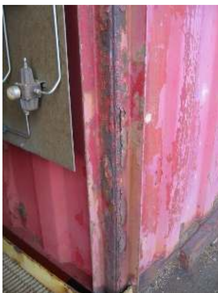
Figuur 29 – Corrosieschade aan verbinding tussen barrières
