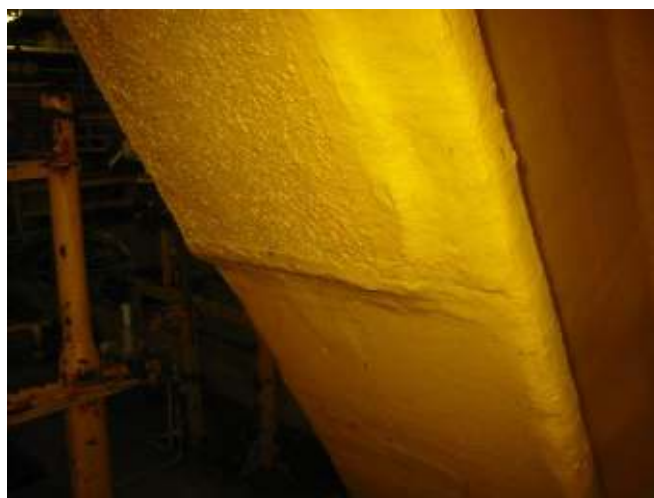
Figuur 51 – Reparatie van LWC materiaal met opschuimende epoxy
