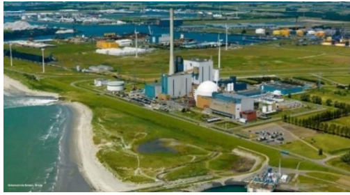
Figuur 3.2 Kernenergiecentrale Borssele
