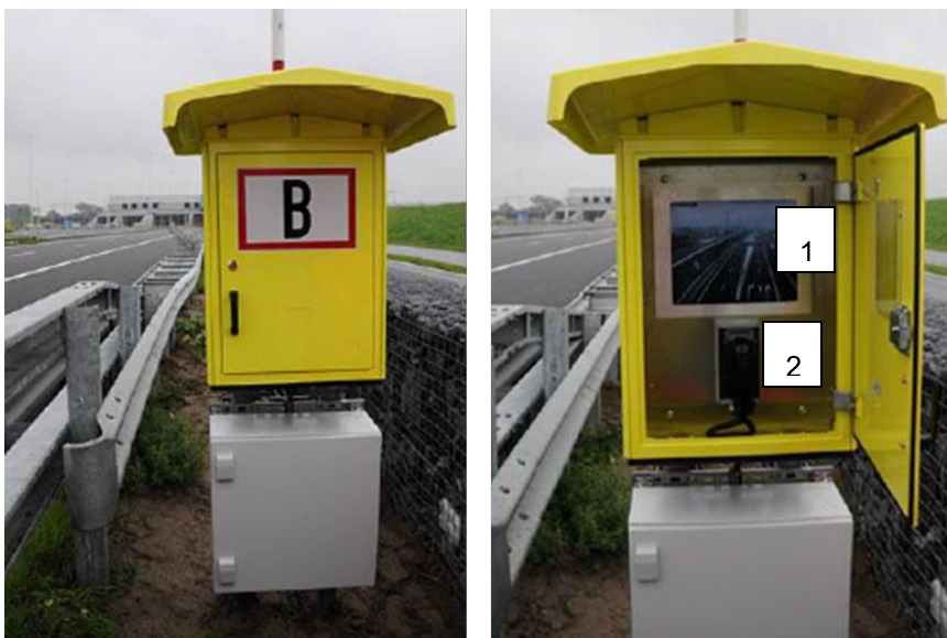
Figuur 5. Hulpdienstinformatiepaneel, links gesloten, rechts geopend; 1: beeldscherm, 2: intercom
