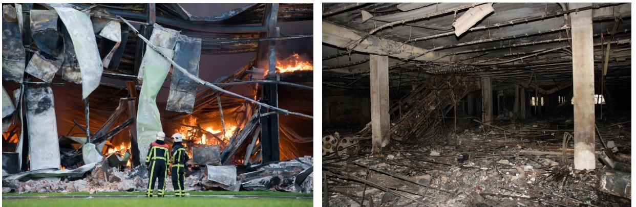
Figuur 4.8 Draagconstructies bij brand (Bron: E.J. Huizer)
