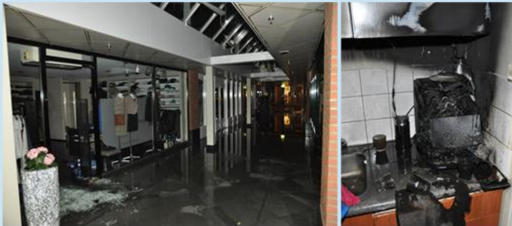
Figuur 2.1 Links de winkel, rechts het koffiezetapparaat dat heeft gebrand (Bron: TBO VGGM)
