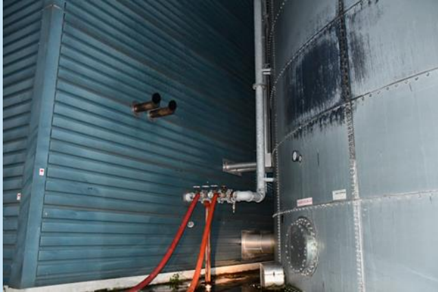
Figuur 3.1 Aanvullen van de watervoorraad via de daarvoor aangebrachte aansluitingen (Bron: TBO VRR/VRZH)
