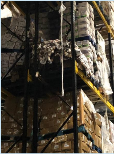
Figuur 3.2 Als gevolg van de brand is het wikkelfolie losgeraakt (Bron: TBO VGGM)
