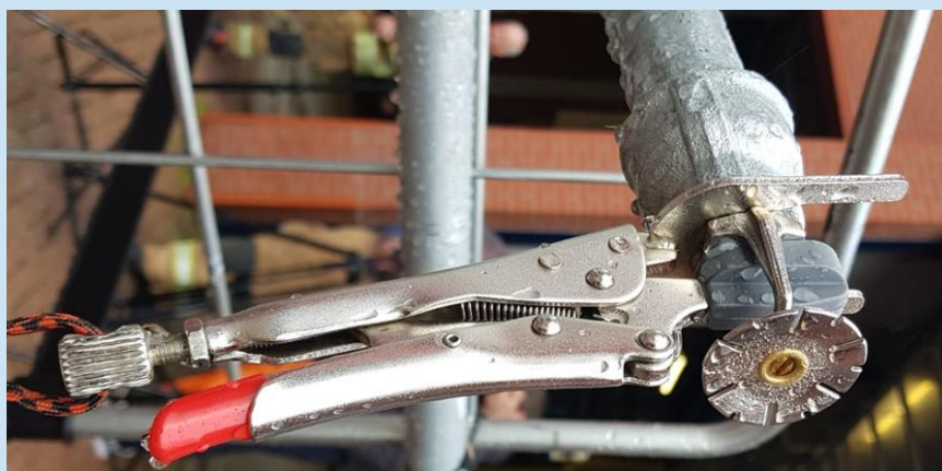
Figuur 4.5 Sprinklertang op sprinklerkop (Bron TBO VRR/VRZHZ)
