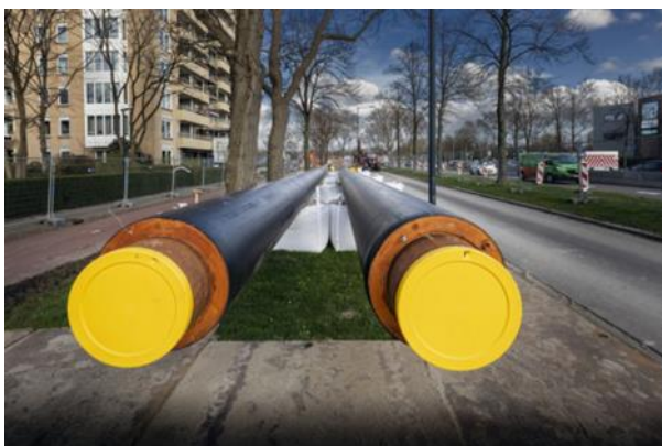
Figuur 10.2 Hogedruk warmtetransportleidingen (bron: WarmtelinQ, 2023)
